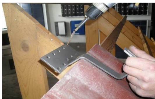
Montáž háku na krov
