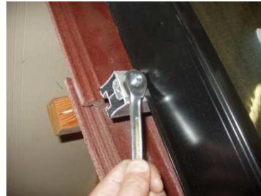
Montáž kolektoru pomocí příložky k Al profilu
