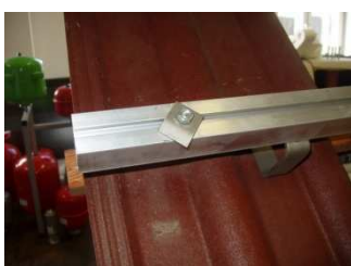
Umístění jezdce včetně příložky doprofilu.
