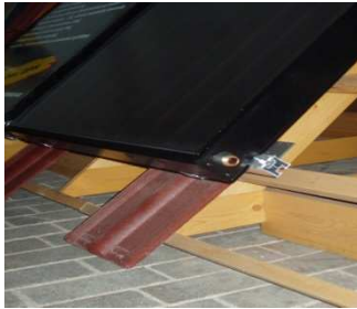
Montáž kolektorů na konstrukci
