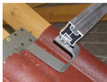
Montáž Al profilu na hák
