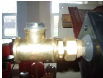
Montáž odvzdušnění na horní vývod kolektoru
