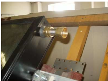
Montáž propojovací sady mezi kolektory.
