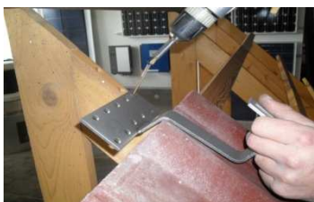
Montáž háku na krov
